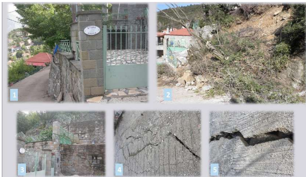
Εικόνα 11. Άποψη των βλαβών λόγω της κατολίσθησης στην ιδιοκτησία Χατζηνικολάου (φωτο 1,2,3), καθώς και στον άνω κεντρικό δρόμο της Περίστα (φωτο 4,5).
