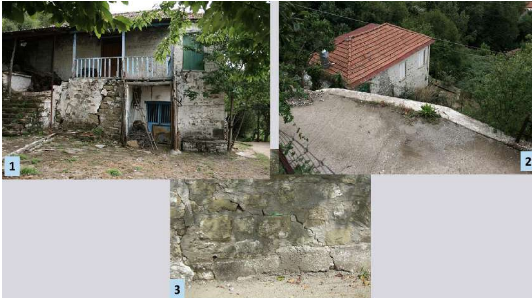
Εικόνα 8. Άποψη των βλαβών που έχουν υποστεί τα δύο σπίτια ανάντη (1) και κατάντη (2) του δρόμου, καθώς και του εσωτερικού τοίχου αντιστήριξης (3).
