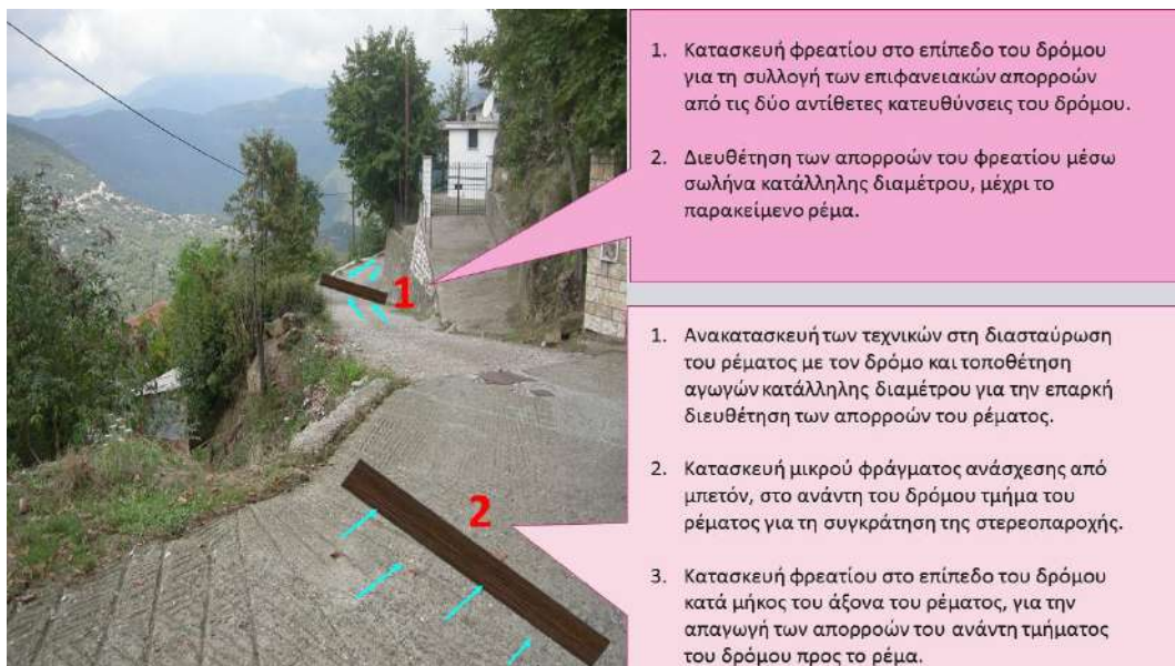
Εικόνα 10. Προτεινόμενα μέτρα στις δύο θέσεις παρέμβασης
