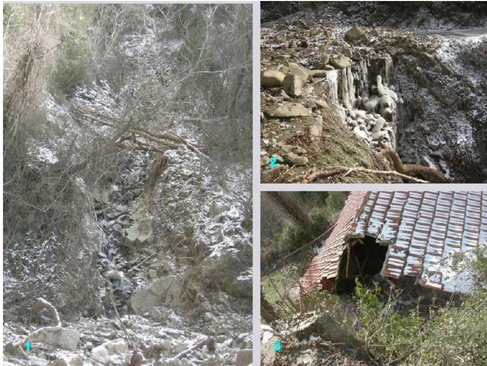
Εικόνα 14. Άποψη της κοίτης του ρέματος με τα εκατέρωθεν υπολείμματα της λασποροής (1), της απόθεσης των υλικών στο επίπεδο του δρόμου (2) και της σοβαρής βλάβης του σπιτιού από τον μεταφερμένο ογκόλιθο (3).
