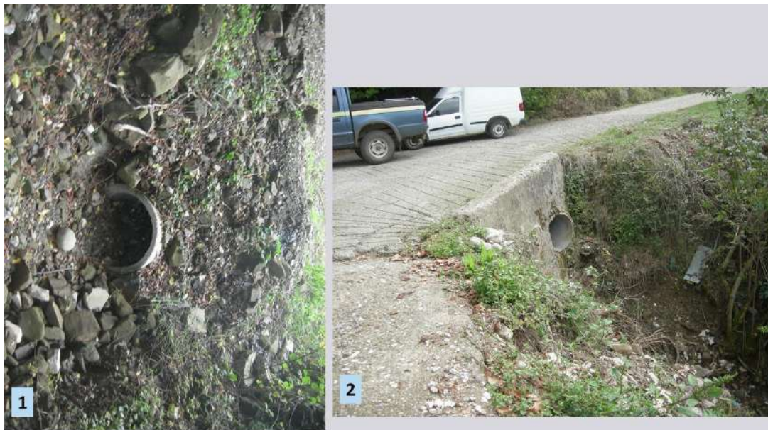
Εικόνα 9. Τα υπάρχοντα τεχνικά στη διασταύρωση του ρέματος με το δρόμο, είναι μικρής διαμέτρου και έχουν αποφραχθεί από τα στερεο-υλικά, που μεταφέρει το ρέμα.
